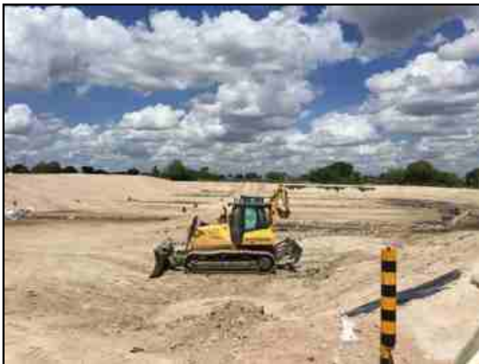
Figura 114 – Trator esteira para compactação dos resíduos Fonte: Premier Engenharia, 2021.
