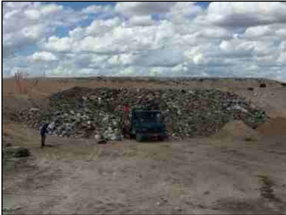
Figura 106 – Vista da atual frente de trabalho do aterro Fonte: Premier Engenharia, 2021.
