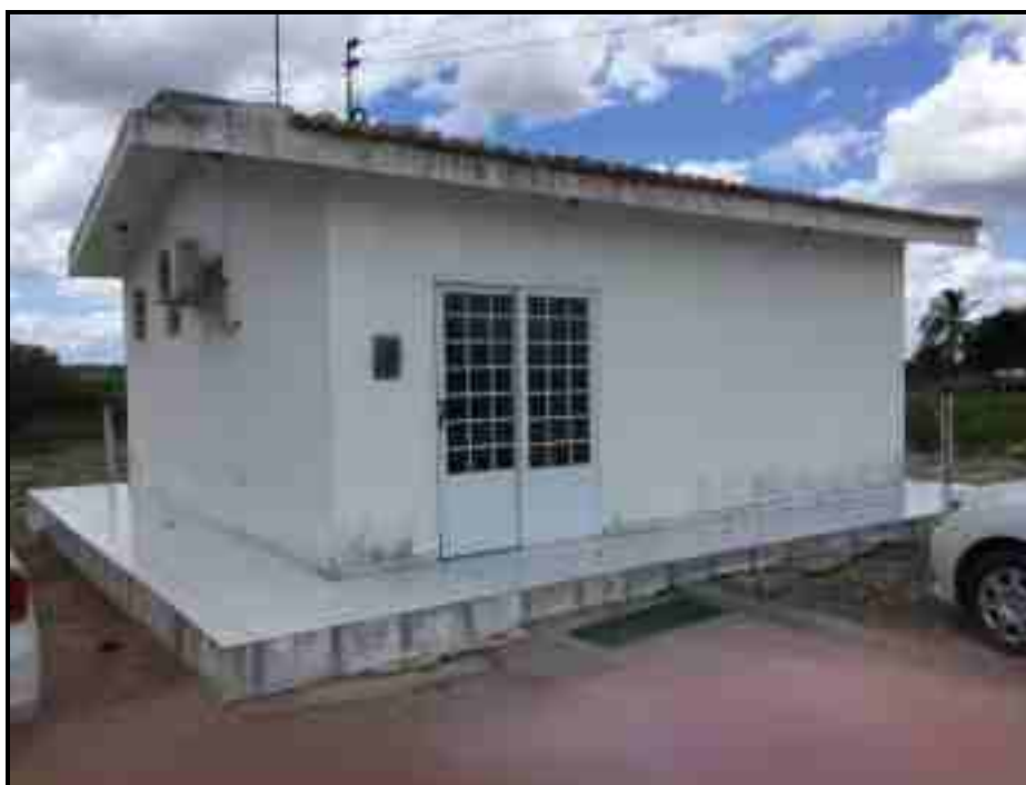
Figura 111 – Escritório administrativo anexo ao aterro sanitário Fonte: Premier Engenharia, 2021.
