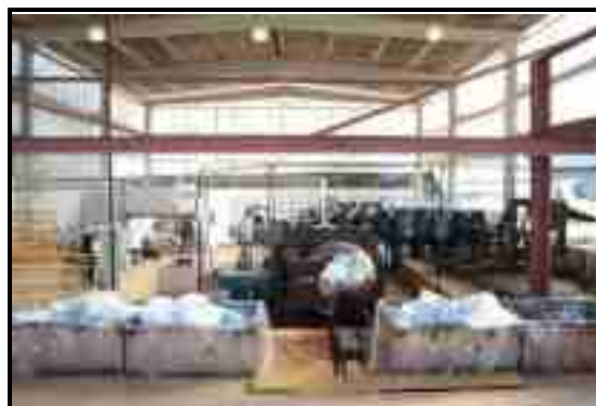
Figura 12 - Local de tratamento dos RSS na sede da Empresa SERQUIP Fonte: SERQUIP, 2020.
