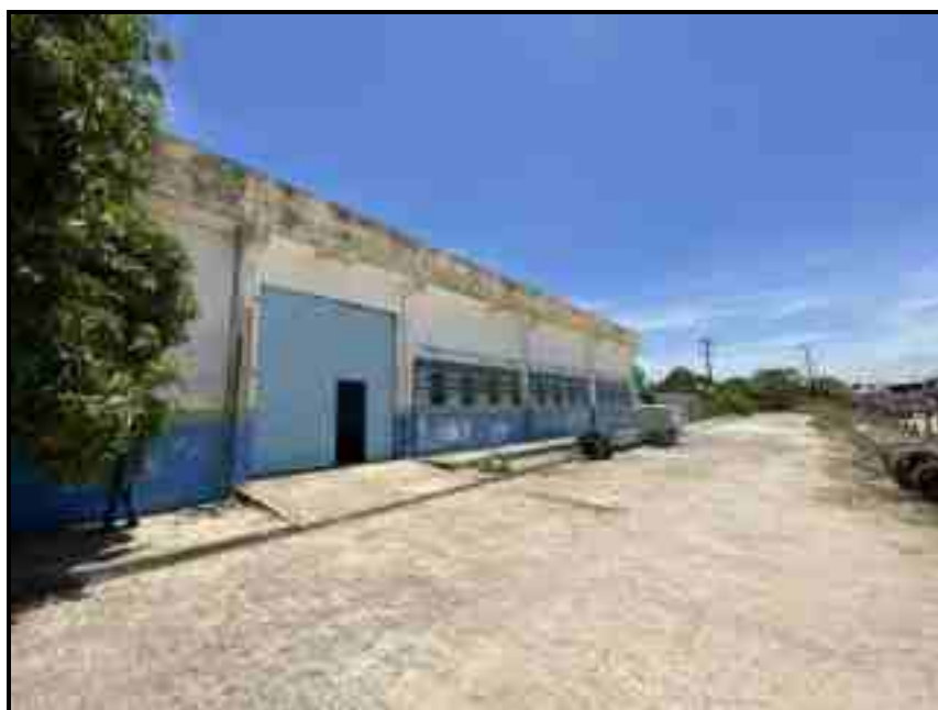
Figura 42 - Vista externa da ERAT-1 Fonte: Premier Engenharia, 2021.
