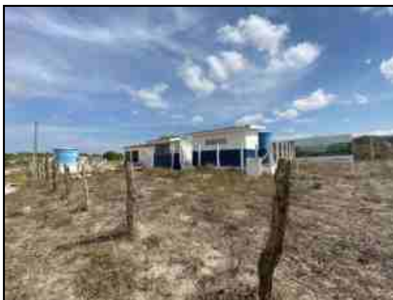
Figura 55 – Dessalinizador – Sítio Baixa da Boneca (São José) Fonte: Premier Engenharia, 2021.
