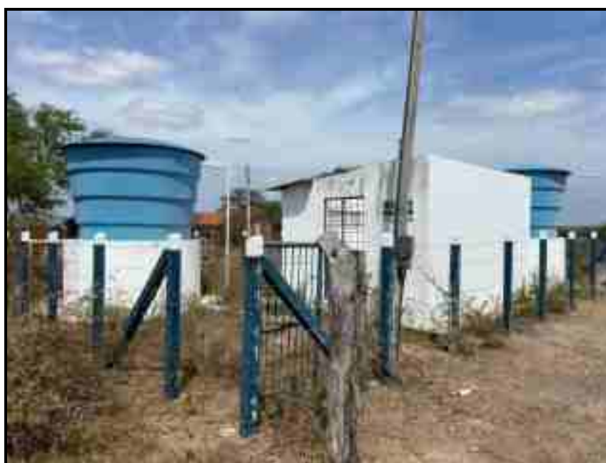
Figura 60 – Sistema Abastecimento – Sítio Lageiro Bonito Fonte: Premier Engenharia, 2021.
