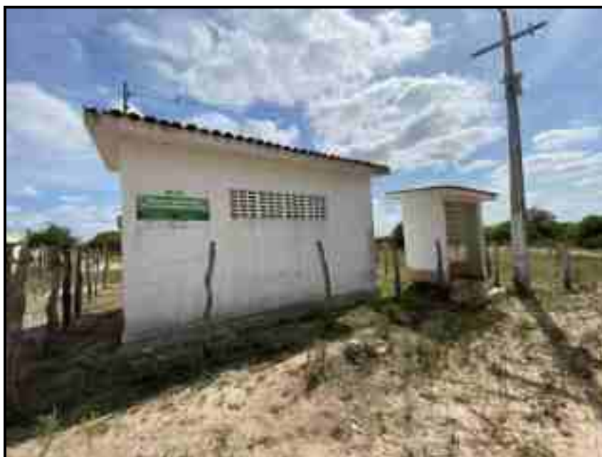
Figura 75 –Vista Sistema 2 – Povoado Serrinha dos Cocos Fonte: Premier Engenharia, 2021
