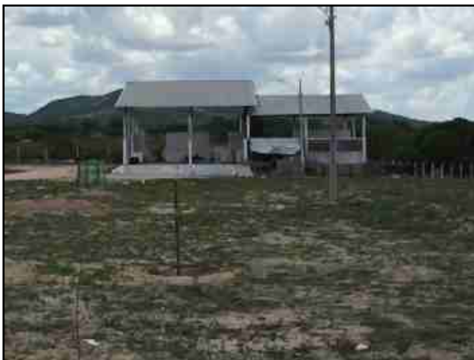
Figura 112 – Área de triagem para recicláveis Fonte: Premier Engenharia, 2021.
