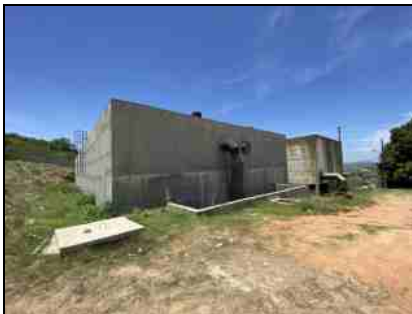
Figura 77 – Reservatórios R-01 e R-02 – Olho D'água das Flores Fonte: Premier Engenharia, 2021.
