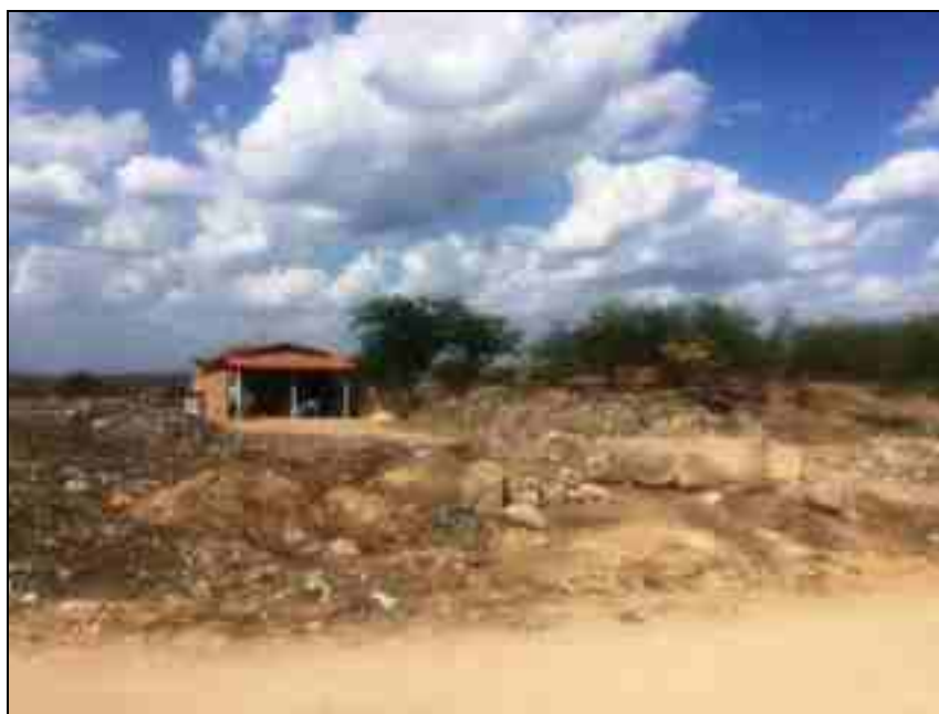
Figura 121 – Presença de casas na área do antigo lixão Fonte: Premier Engenharia, 2021.
