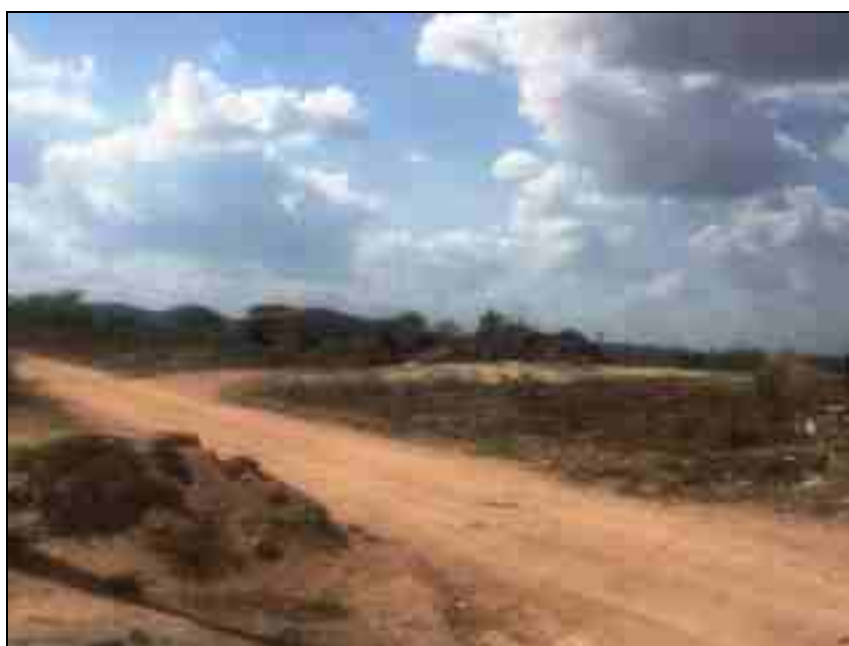
Figura 120 – Vista geral da área do antigo lixão Fonte: Premier Engenharia, 2021.
