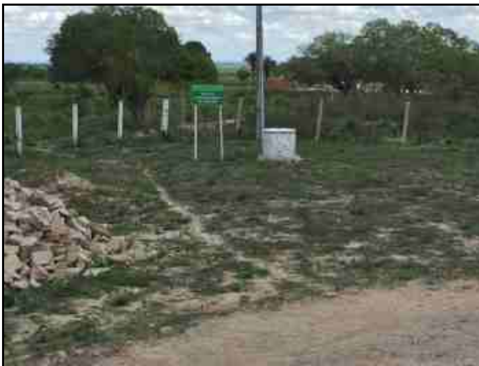
Figura 113 – Poços de monitoramento do chorume Fonte: Premier Engenharia, 2021.
