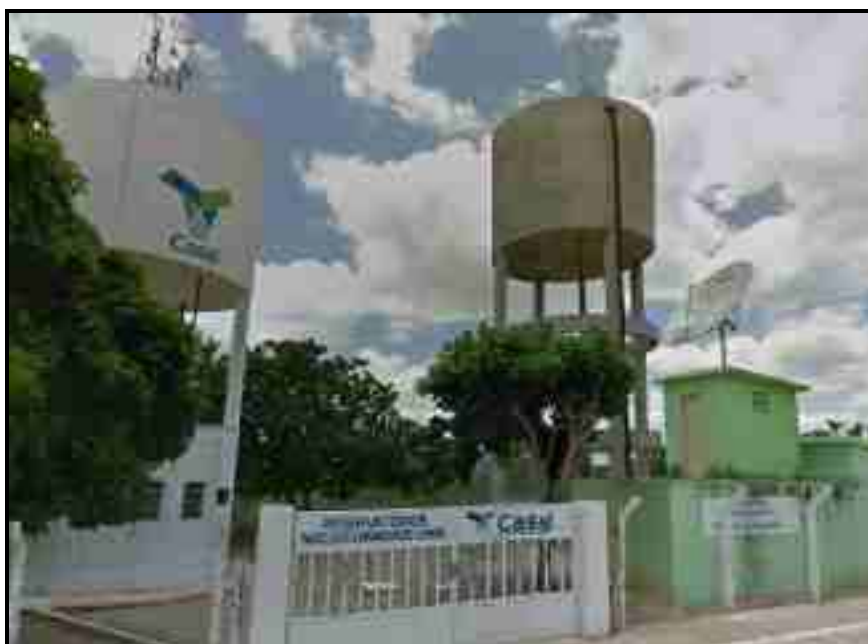
Figura 48 – Reservatório R03 – Município de Carreiros Fonte: Google Earth, 2021.
