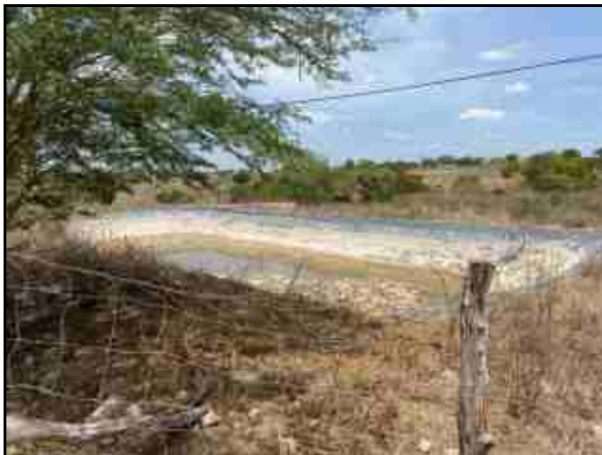
Figura 64 – Tanque de Efluentes – Sítio Malhadinha 2 Fonte: Premier Engenharia, 2021.
