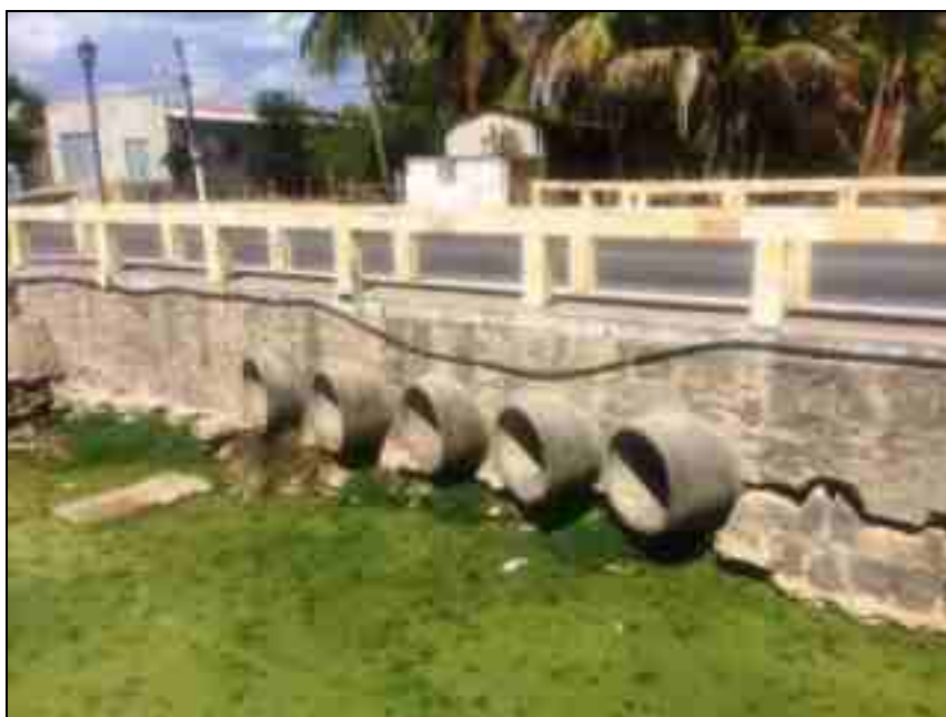
Figura 123 – Travessia/bueiro sobre o Riacho Salgadinho (Ponto A) Fonte: Premier Engenharia, 2021.
