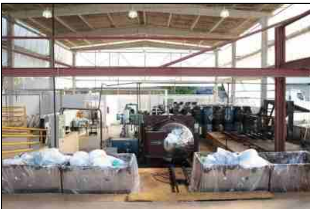
Figura 118 – Local de tratamento dos RSS na sede da Empresa SERQUIP Fonte: SERQUIP, 2020.
