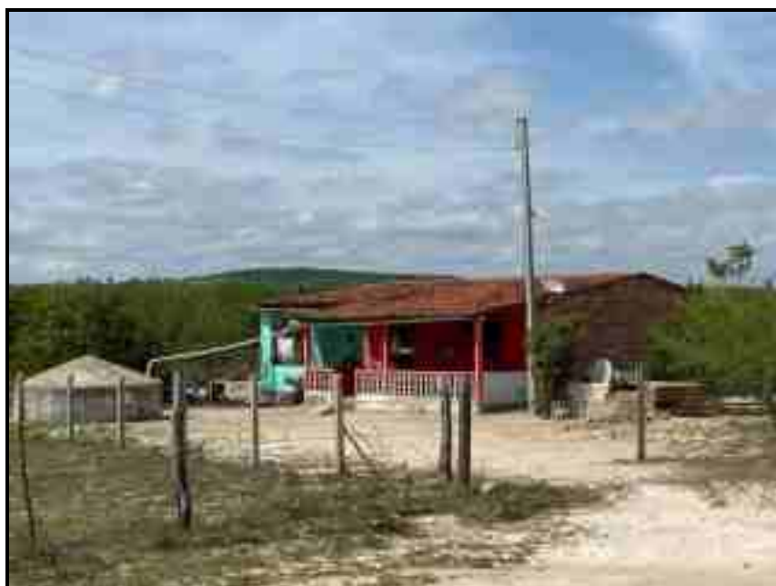
Figura 51 – Cisternas Individuais Fonte: Premier Engenharia, 2021.
