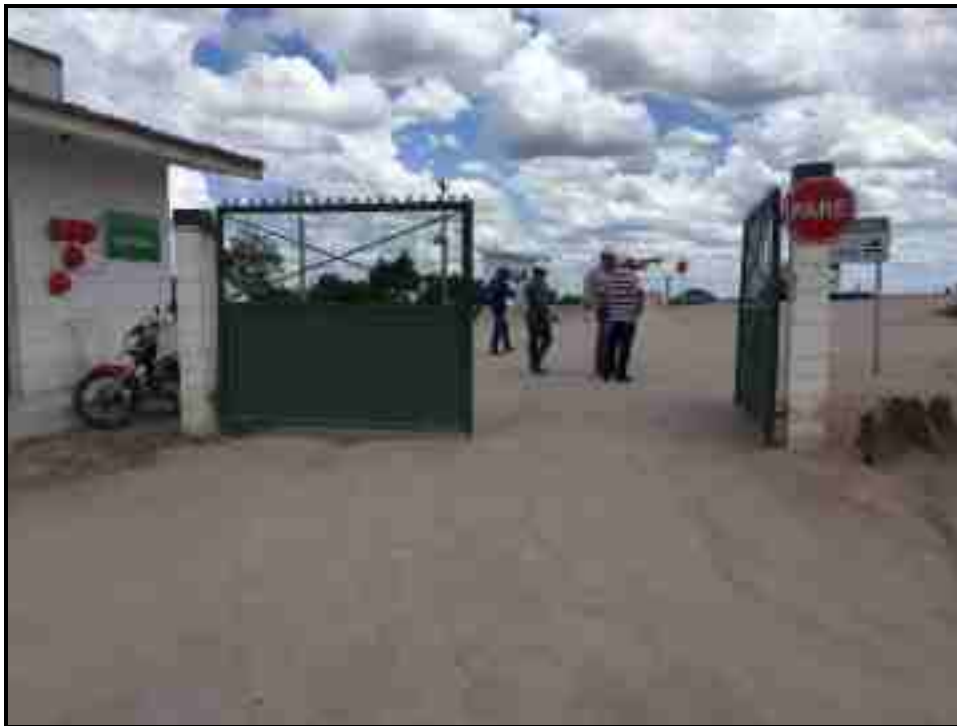
Figura 104 – Portaria e acesso ao aterro sanitário (vista externa)
