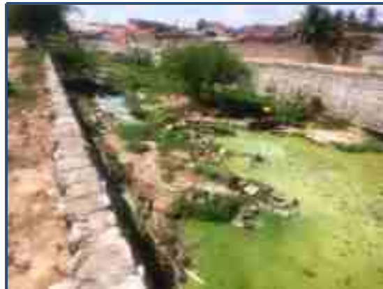
Figura 13 - Presença de esgoto e resíduos sólidos no Riacho Salgadinho Fonte: Premier Engenharia, 2021.
