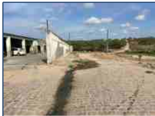
Figura 7 - Lançamento de esgoto próximo ao transbordo de resíduos Fonte - Premier Engenharia, 2021.
