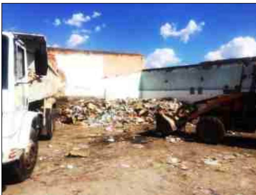
Figura 101 – Vista interna da estação de transbordo Fonte: : Premier Engenharia, 2021.
