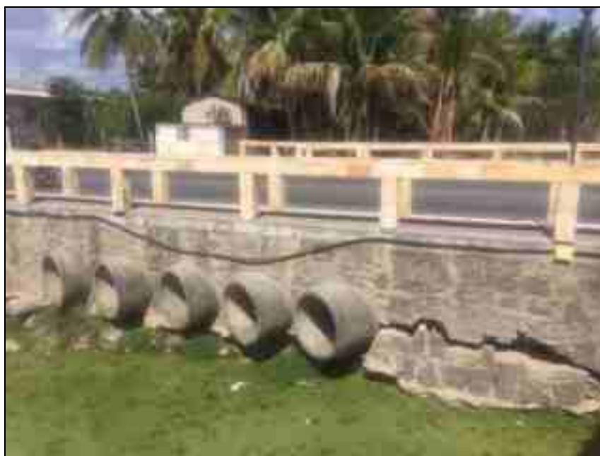
Figura 132 – Riacho Salgadinho: Bueiros sob a travessia (Ponto A) Fonte: Premier Engenharia, 2021.
