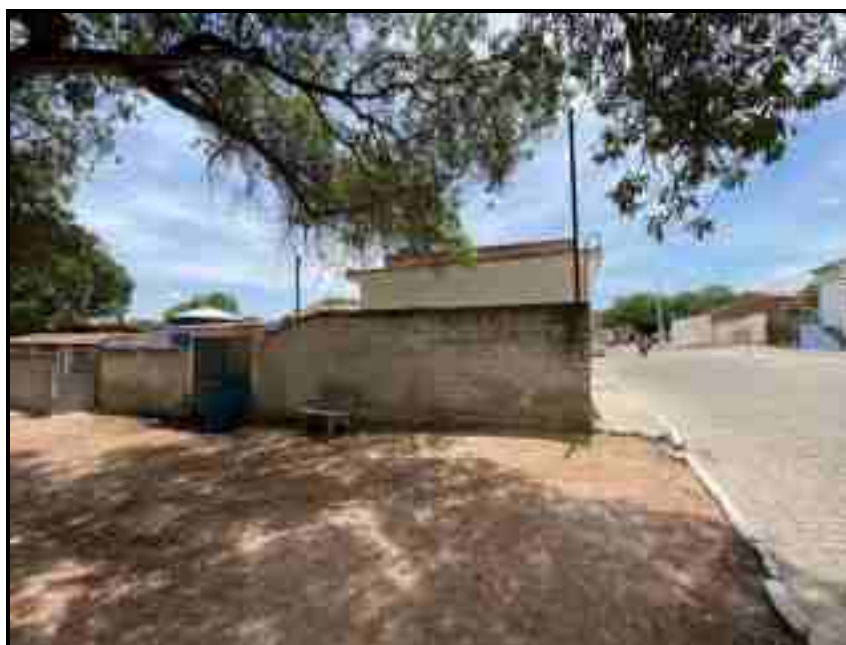
Figura 69 – Dessalinizador – Povoado Candunda Fonte: Premier Engenharia, 2021
