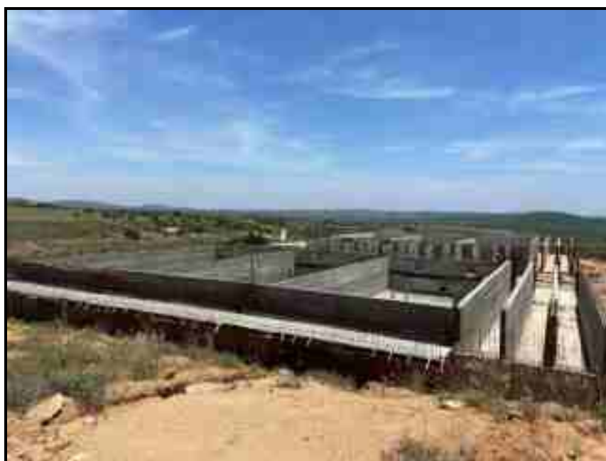
Figura 39 – ETA convencional em construção Fonte: Premier Engenharia, 2018.
