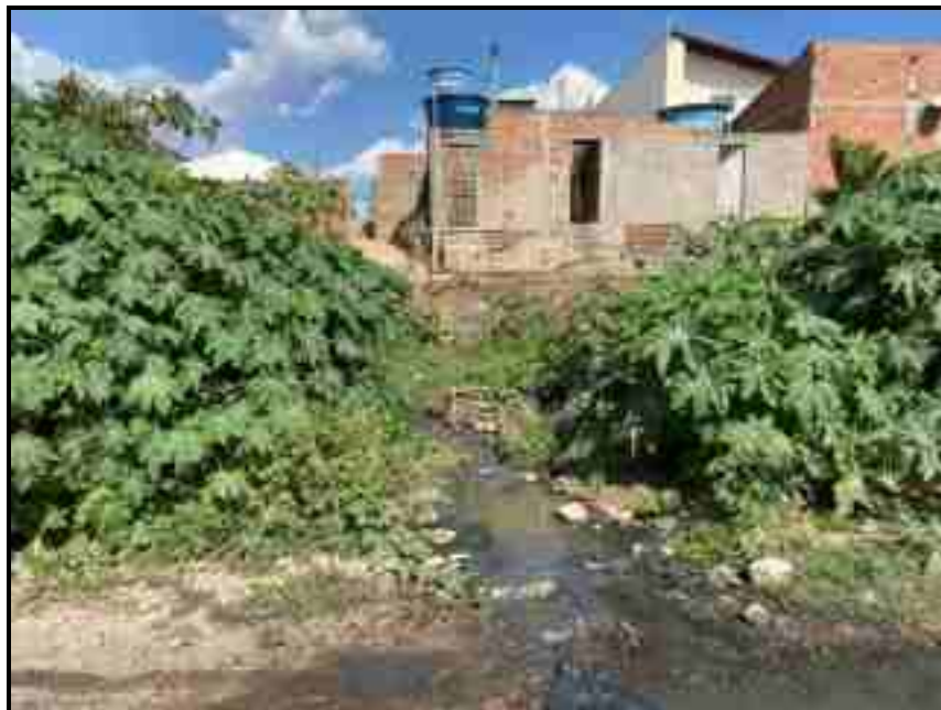
Figura 85 – Lançamento de Esgoto Riacho Grande Fonte: Premier Engenharia, 2021.
