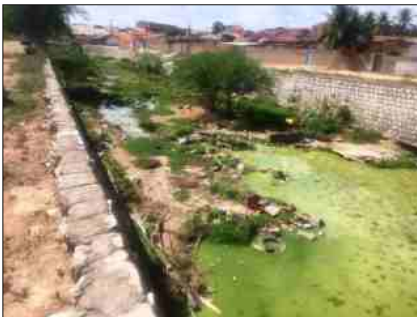
Figura 128 – Presença de esgoto e resíduos sólidos no Riacho Salgadinho Fonte: Premier Engenharia, 2021.
