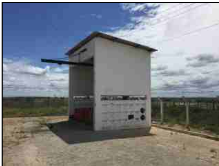
Figura 40 – Vista externa do tratamento Fonte: Premier Engenharia, 2021.
