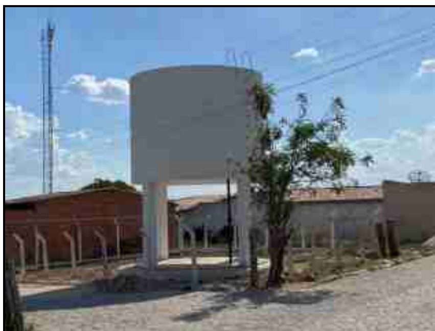
Figura 79 – Reservatórios R-04 – Senador Rui Palmeira Fonte: Premier Engenharia, 2021.
