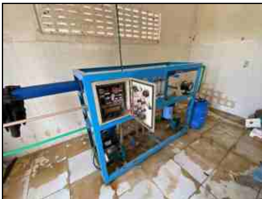
Figura 62 – Dessalinizador – Sítio Malhadinha 2 Fonte: Premier Engenharia, 2021.
