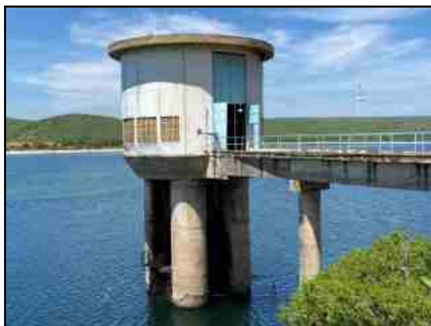
Figura 31 – Captação – Rio São Francisco Fonte: Premier Engenharia, 2021.
