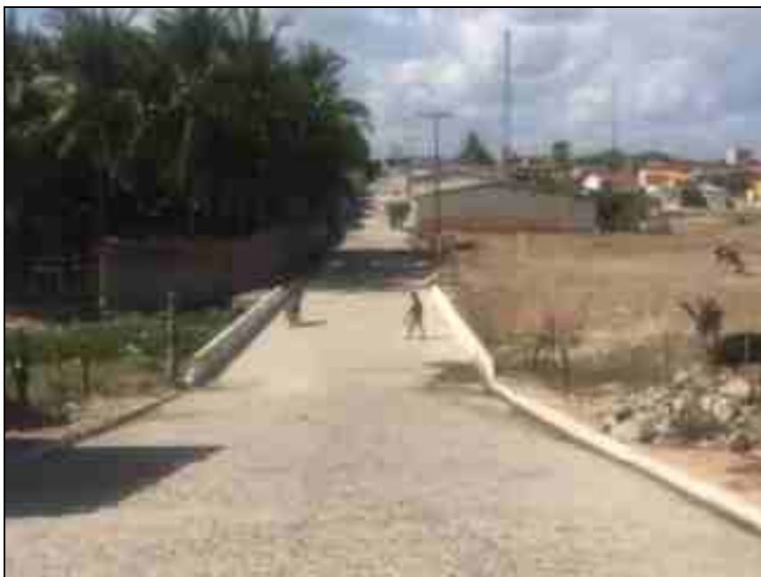
Figura 133 – Riacho Salgadinho: Travessia (Ponto B) Fonte: Premier Engenharia, 2021.
