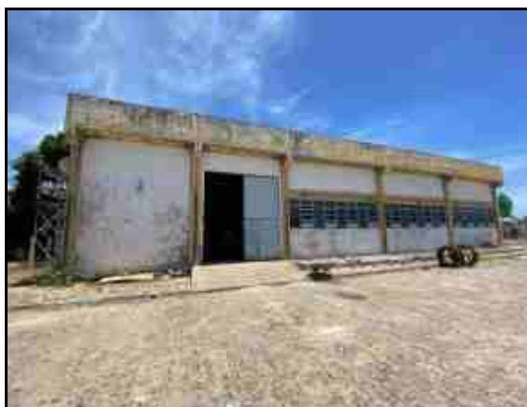
Figura 34 – Vista externa da ERAB-2 Fonte: Premier Engenharia, 2021.
