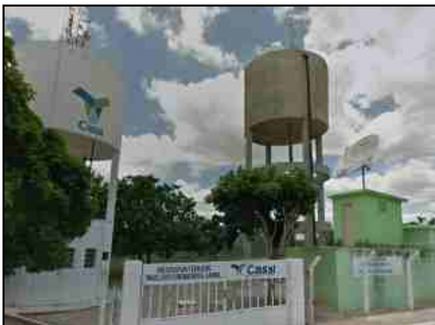
Figura 78 – Reservatórios R-03 – Carneiros Fonte: Google Earth, 2021.
