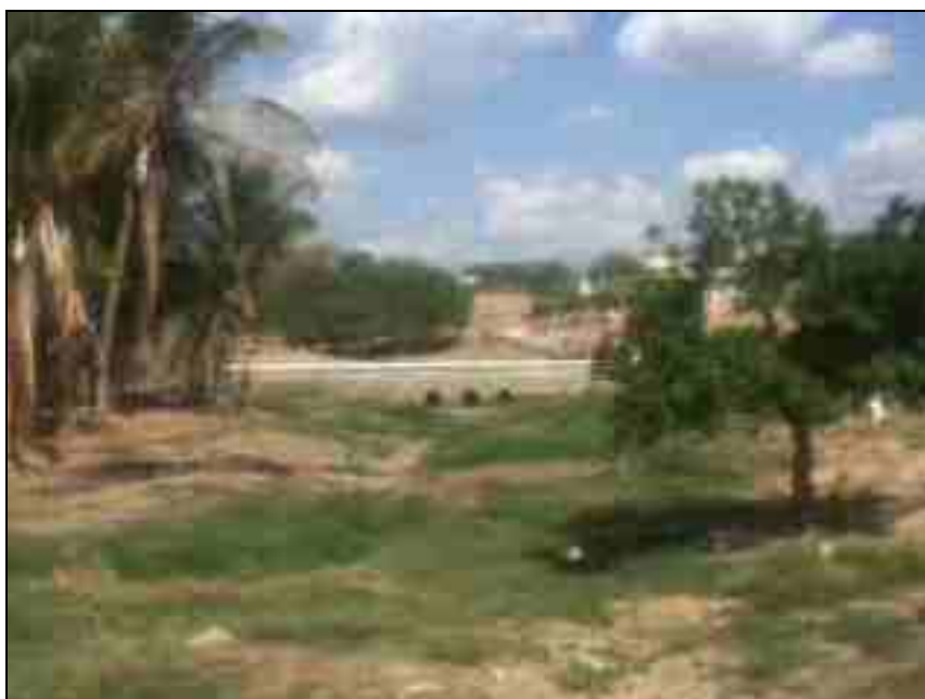
Figura 124 – Travessia/bueiro sobre o Riacho Salgadinho (Ponto B) Fonte: Premier Engenharia, 2021.
