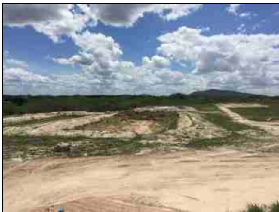
Figura 110 – Sistema de lagoas (tratamento do percolado) Fonte: Premier Engenharia, 2021.
