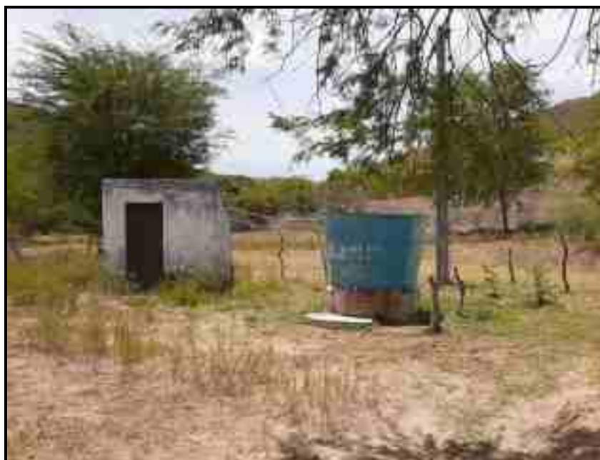
Figura 59 – Poço Artesiano – Sítio Cava Ouro Fonte: Premier Engenharia, 2021.
